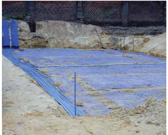
Erdwärme-Kompaktkollektor (Kapillarrohrsystem)
