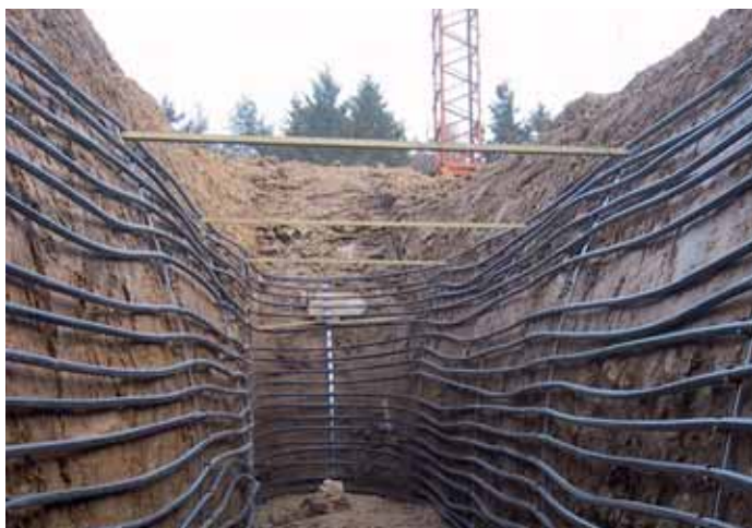
Einbau eines Grabenkollektors als flächensparende Variante
