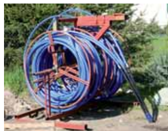
Doppel-U-Sonde aus elastischem Kunststoff. Rechts sieht man den Sondenkopf, der die Sonde nach unten hin abschließt. Mit Hilfe eines Gewichtes, das am Sondenkopf montiert wird, wird die Sonde in das Bohrloch niedergebracht. Quelle: LBGR – N. Schlaak
