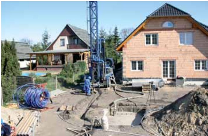
Bohrkran mit Spülungsgrube Quelle: LBGR – N. Schlaak
