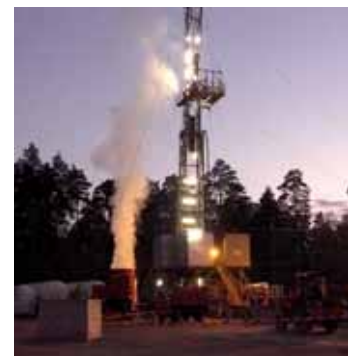
Bohrung für Forschung zur Geothermienutzung in Groß Schönebeck, Brandenburg Quelle: Deutsches GeoForschungsZentrum (GFZ) Potsdam
