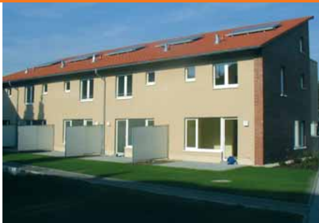
8 Reihenhäuser als Niedrigenergiehäuser
