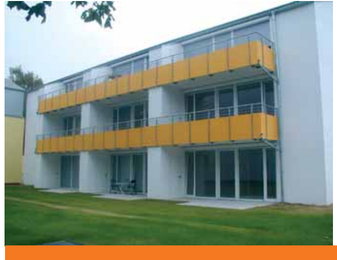
Ansicht mit Fahrstuhlturm und verglastem Laubengang
