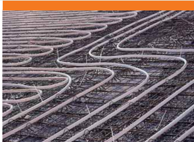
Rohrsystem zur Betonkerntemperierung Foto: Repp GmbH
