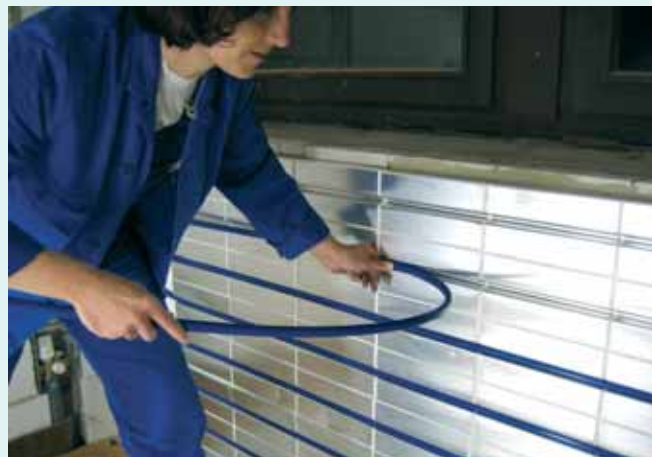
Beispiel einer Wandheizung im Trockenbau
