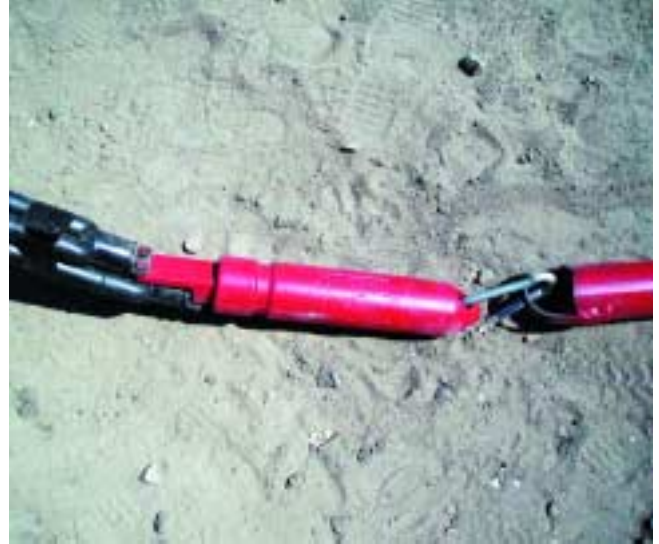
Abbildung 15 und 16: Einbringen des Sondenbündels mittels Haspel (links) und Sondenfuß mit Gewicht (rechts)
