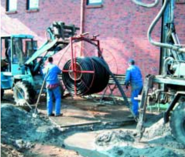
Abbildung 15 und 16: Einbringen des Sondenbündels mittels Haspel (links) und Sondenfuß mit Gewicht (rechts)
